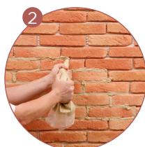
Je réalise les joints
