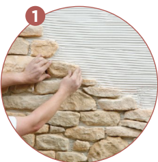
1 Je pose en croisant les joints d'une rangée sur l'autre
