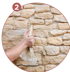
2 Je réalise les joints
